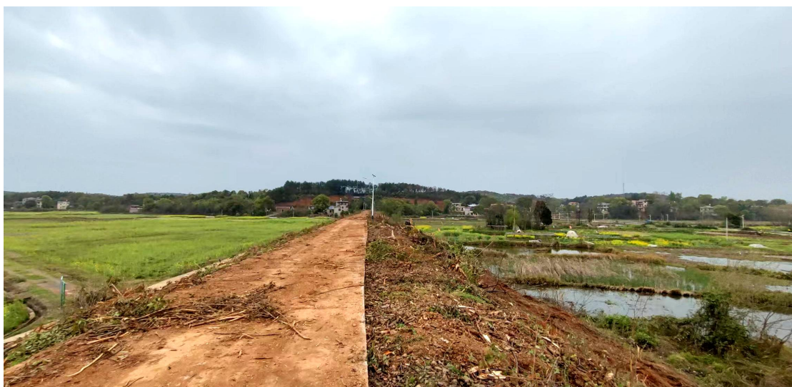
图 2.5 电站非溢流坝照片
