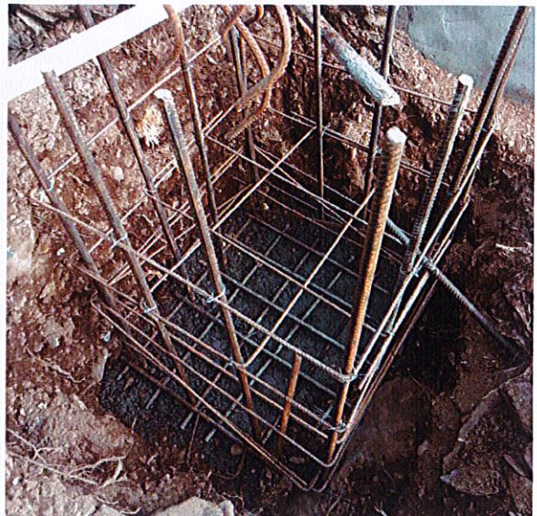
照片 56 格构梁支承墩钢筋制安
