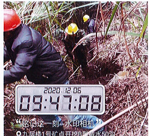
照片12 人工开挖水沟基槽
