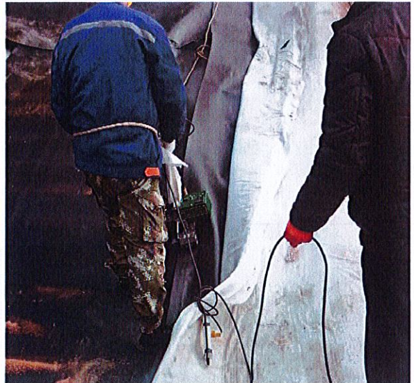
照片8 防渗膜电熔接边
