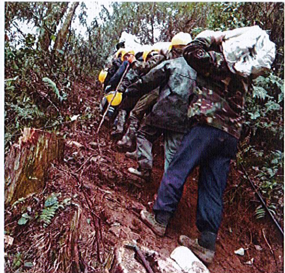
照片 28 人工抬运土工布
