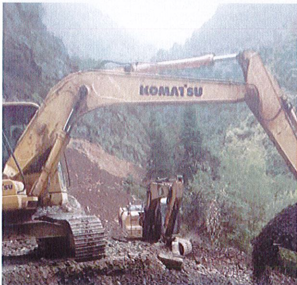
照片5 机械修整坡面
