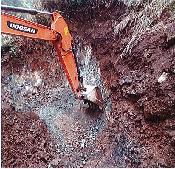
照片 21 机械开挖挡渣墙基槽
