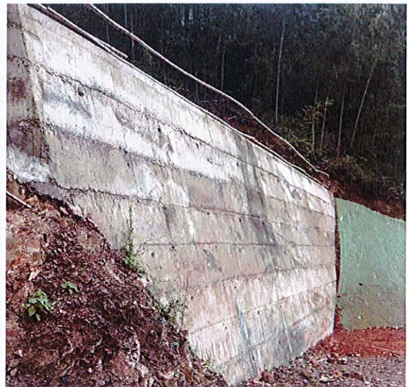
照片 26 完工后的 JIU 挡渣墙-3
