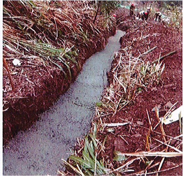
照片 16 水沟底板砼浇筑
