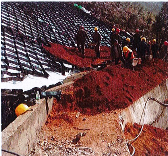
照片11 土工格室覆土
