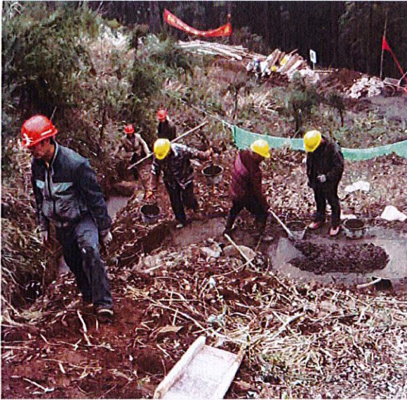
照片 15 人工拌制砼及截水沟底板砼浇筑
