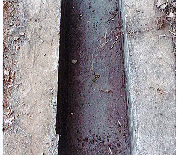
照片 20 完成后的排水沟
