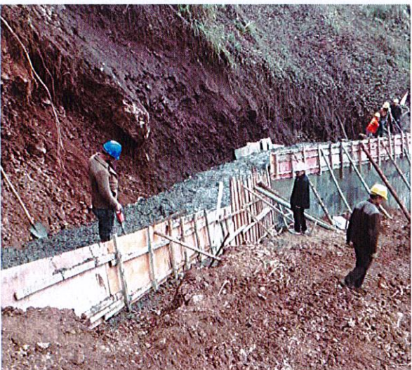
照片 23 挡渣墙砼浇筑
