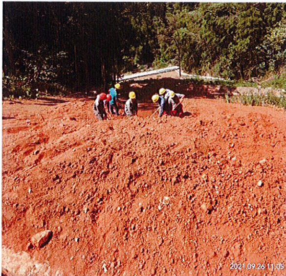
照片 39 人工覆土
