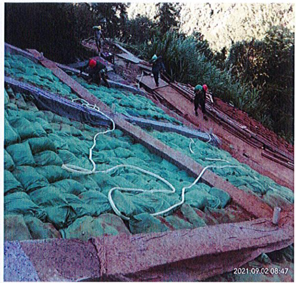
照片 62 格构梁养护
