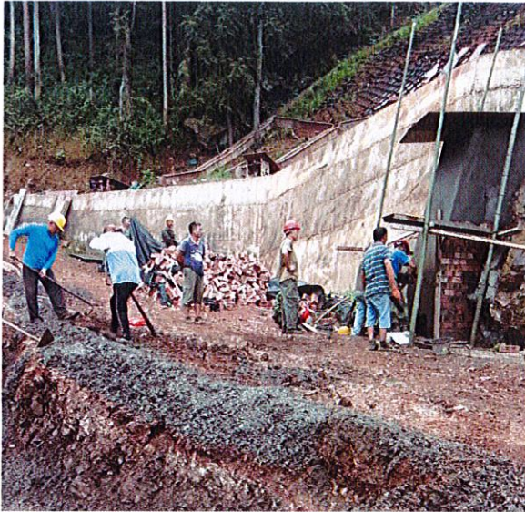
照片 25 完工后的 JIU 挡渣墙-2
