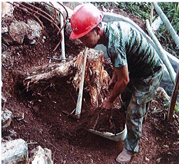
照片 53 人工开挖格构梁支承墩基槽土方
