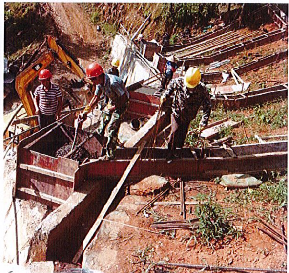
照片 58 格构梁支承墩砼浇筑
