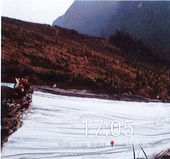
照片7 铺设防渗膜
