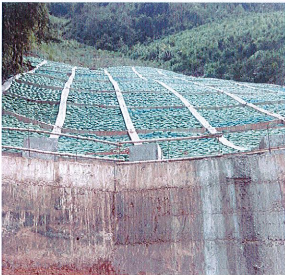
照片 63 完工后的格构梁
