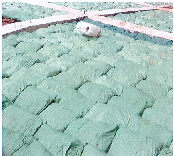
照片 66 完工后的格构梁内植生袋堆码
