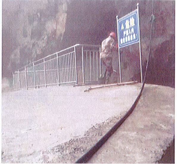
照片 80 消力池防护栏
