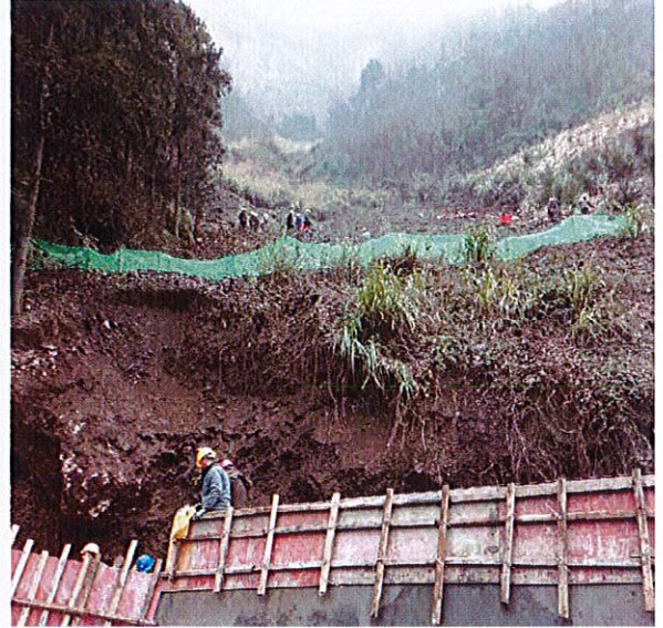
照片 22 挡渣墙支模
