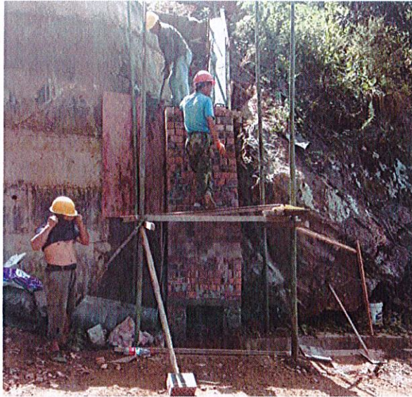
照片 67 落水管砌筑
