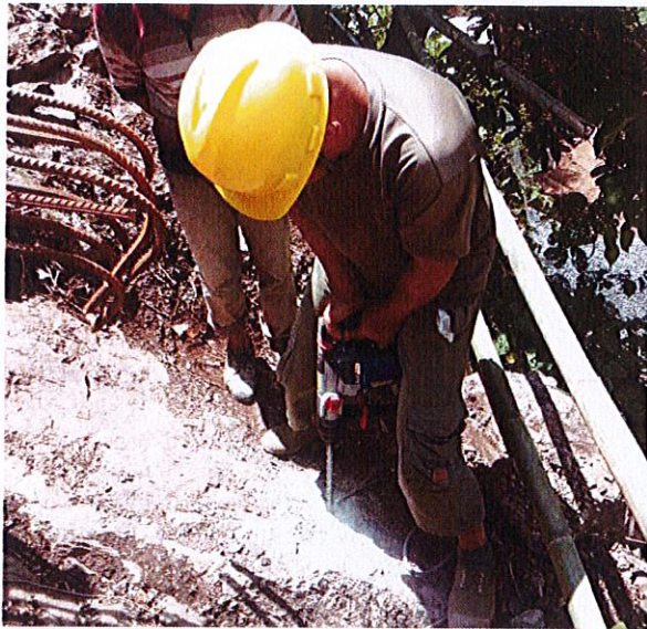
照片 55 造格构梁支承墩基础植筋孔
