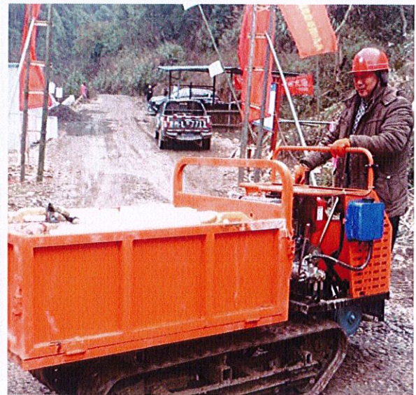
照片 34 爬山虎 (1t) 拖运施工用水
