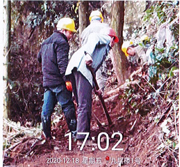
照片 52 人工新建马道
