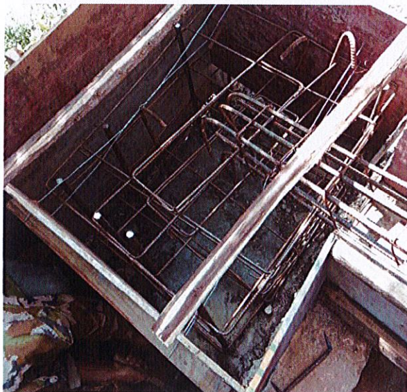
照片 57 格构梁支承墩支模
