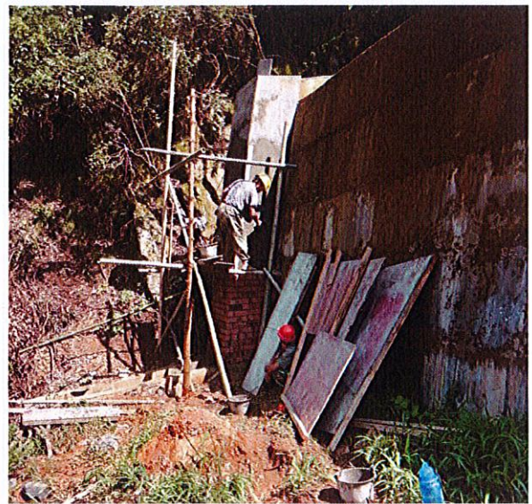
照片 68 落水管水泥砂浆抹面
