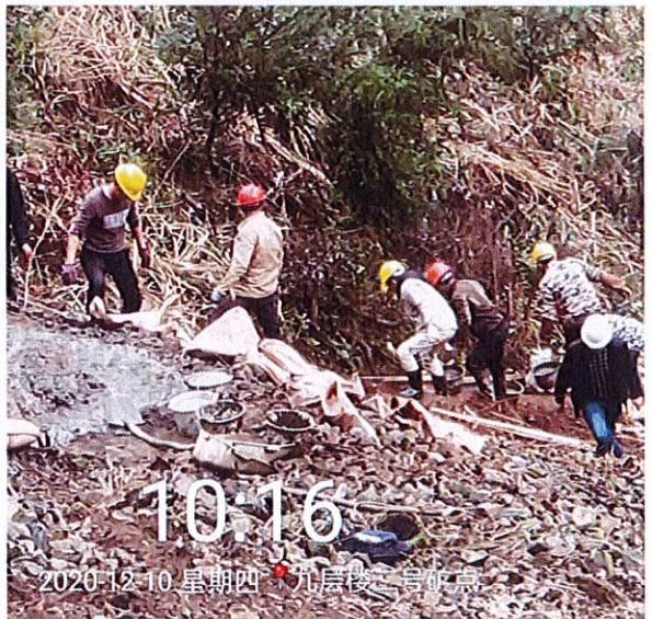
照片 18 水沟砼浇筑
