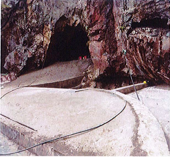
照片 79 消力池完工后
