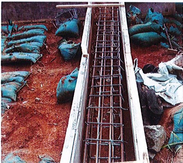
照片 59 格构梁钢筋制安
