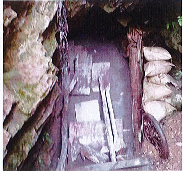
照片 74 矿硐封堵完工后
