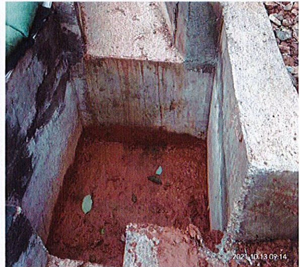
照片 70 完工后的集水井
