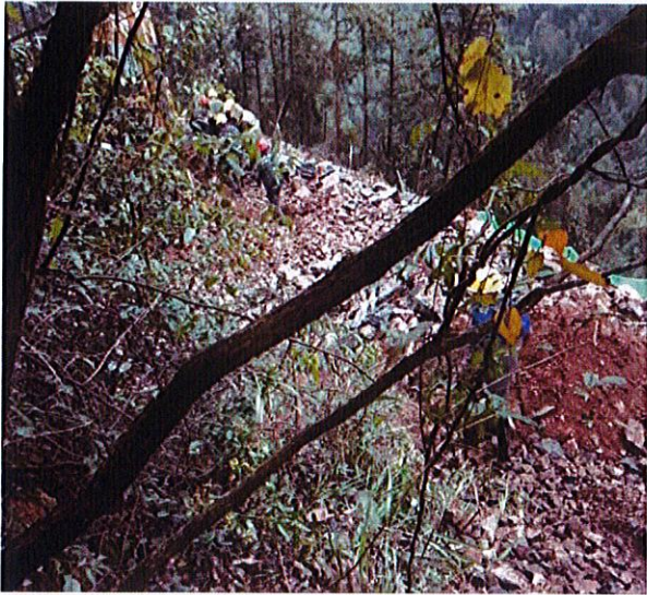
照片3 人工修整坡面
