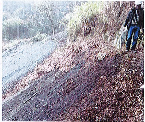
照片2 人工清除杂草完成后
