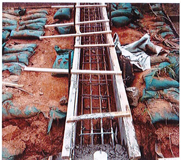
照片 60 格构梁支模
