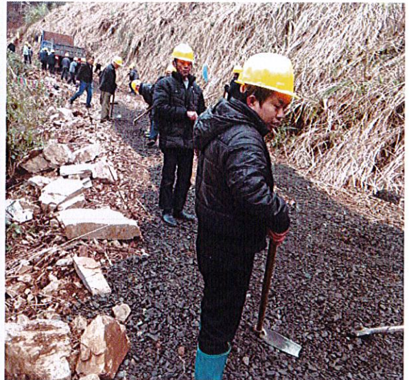
照片 38 人工铺施工便道碎石
