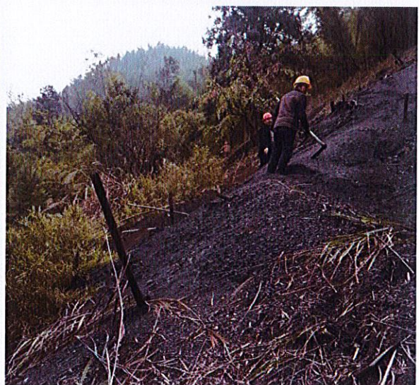
照片4 人工修整坡面
