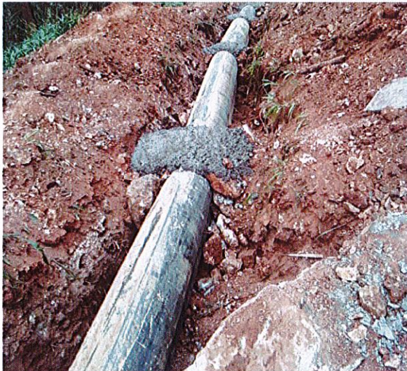
照片 69 铺设过路涵管
