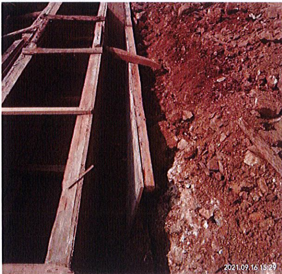
照片 17 水沟支模
