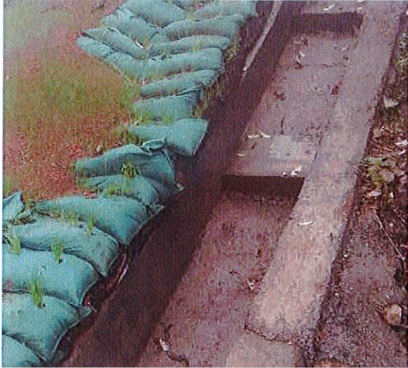
照片 19 完成后的截水沟
