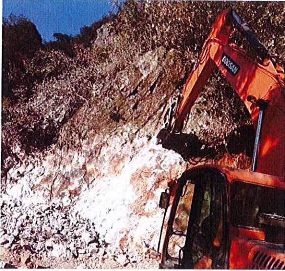
照片 37 机械凿施工便道岩石
