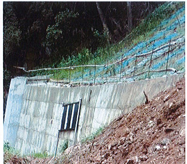
照片 24 完工后的 JIU 挡渣墙-1
