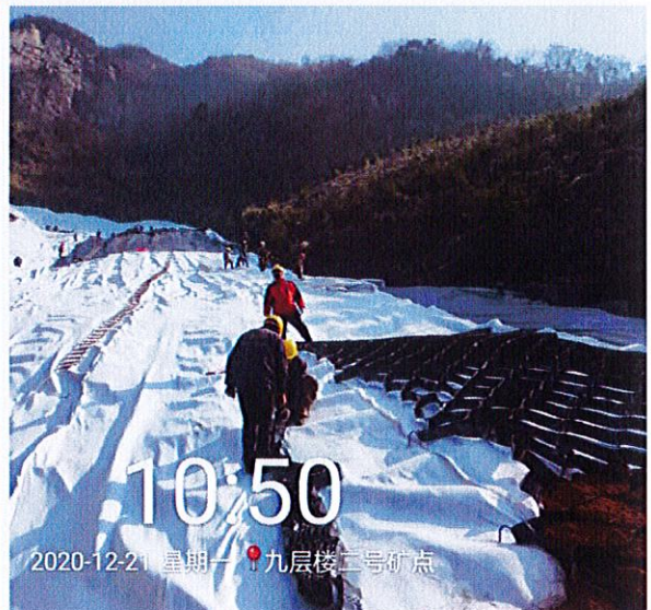
照片10 铺设土工格室
