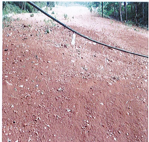
照片 40 完成后的坡面覆土
