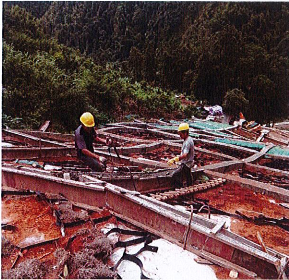
照片 61 格构梁砼浇筑
