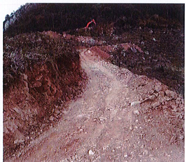
照片 36 机械开挖施工便道
