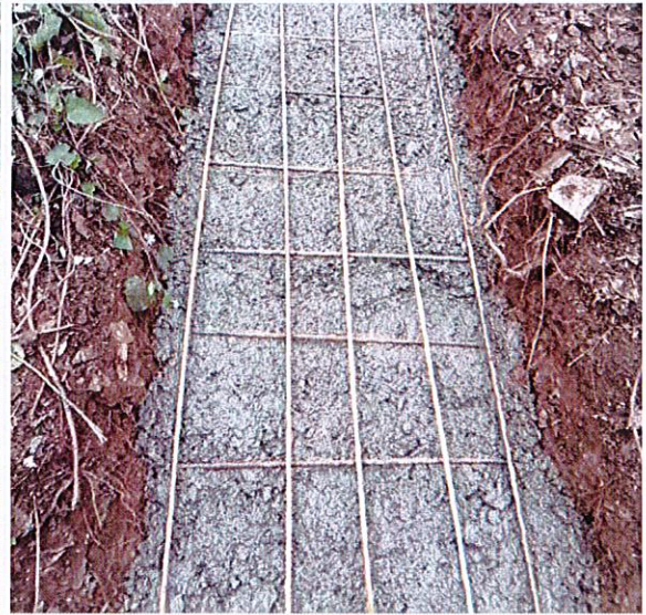
照片 14 水沟铺设钢筋
