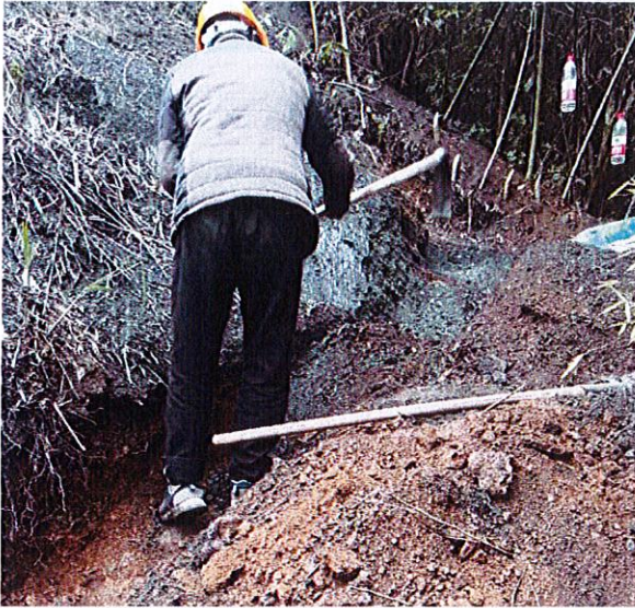
照片 13 人工开挖水沟基槽
